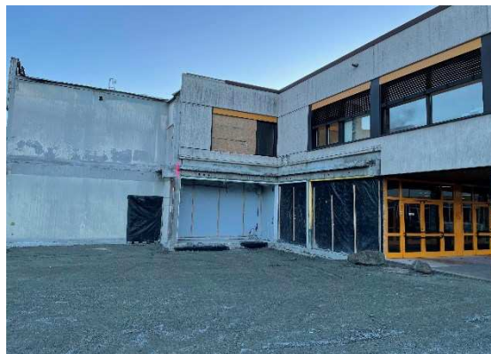
Die Baumaßnahmen gehen weiter
